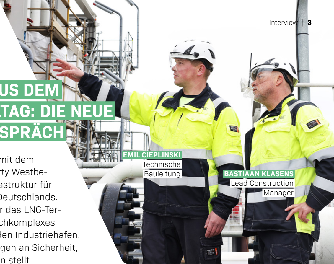
Bastiaan Klasens und Emil Cieplinski inspizieren auf einem ihrer täglichen Rundgänge die Baustelle.
