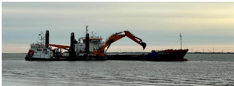
Baggerarbeiten des Stelzenpontonbaggers „Goliath“
