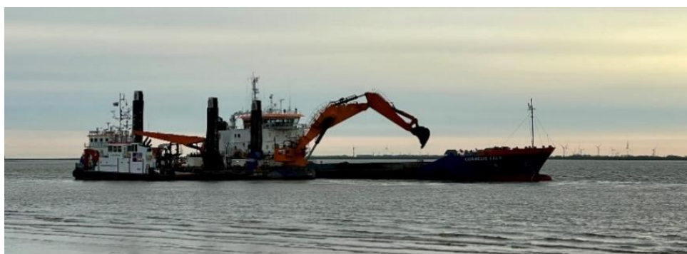
Baggerarbeiten des Stelzenpontonbaggers „Goliath“
